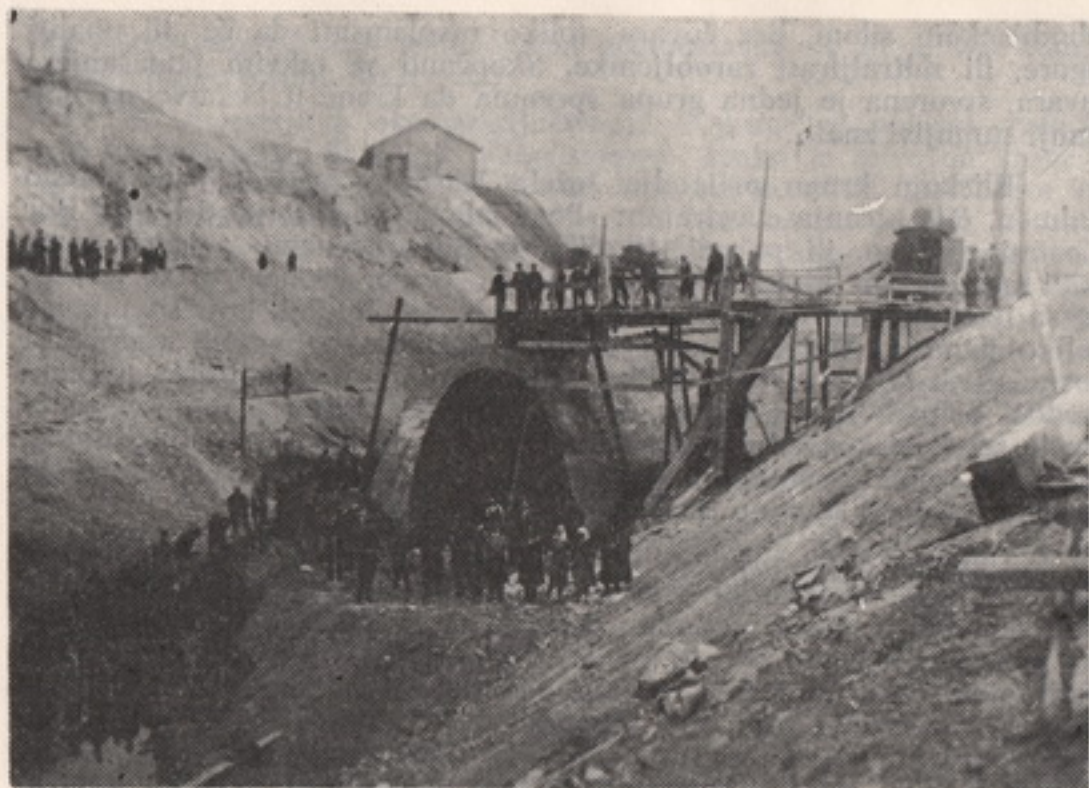
Izgradnja tunela »Borska reka«
