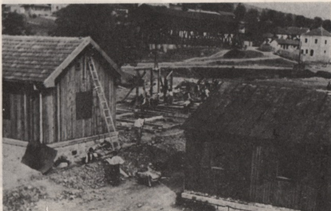
Izgradnja logorskih baraka
