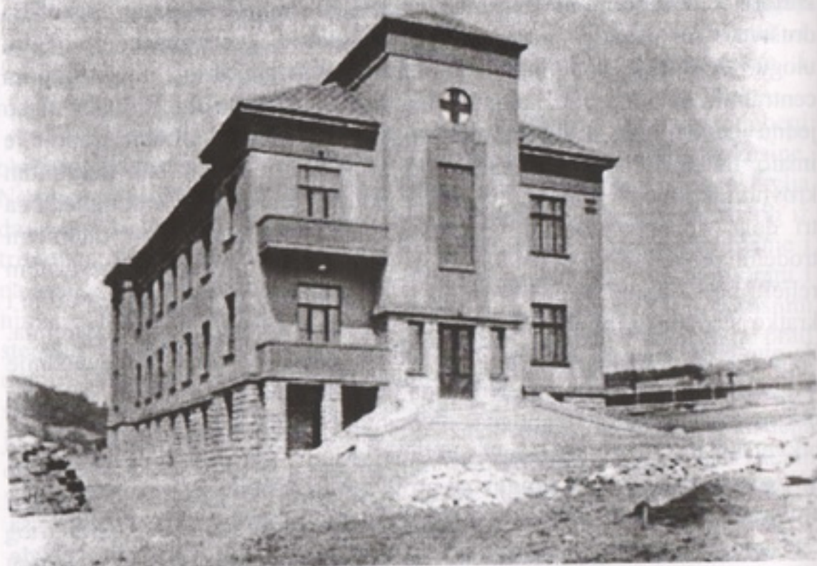
Zgrada bolnice, istočna ulazna fasada
