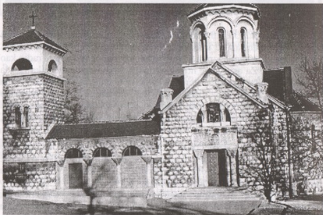
Izgled crkve Svetog Đorđa sa zapadne strane, trenutno stanje
