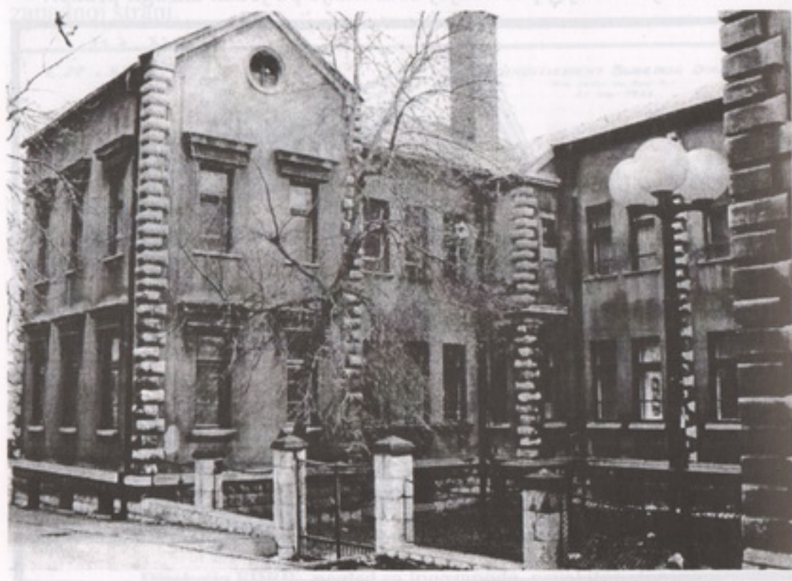
Direkcija FDBR, trenutno stanje, pogled sa severne strane
