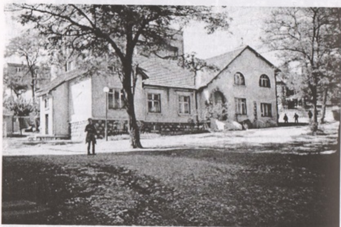
Kuća za sveštena lica, trenutno stanje, pogled sa istoka
