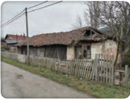
Сл. 37. Северна фасада.
