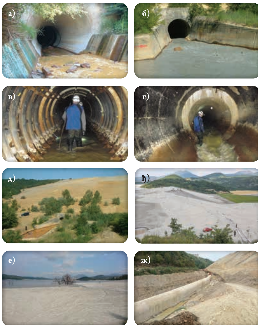
Слика 3.2. Фотографије флотацијског јаловишта Велики Кривељ са датумима фотографисања: а) улаз у тунел Кривељске реке испод Бране 1 – 4. 7. 2012. б) излаз из колектора Кривељске реке испод Бране 3 – 6. 6. 2012. в) колектор Кривељске реке испод Поља 2 – саниран металном подградом – 13. 1. 2014. г) колектор Кривељске реке испод Поља 2 – сужење због санације армираним бетоном – 10. 11. 2014. д) Брана 3, у чијем подножју се види излаз из колектора Кривељске реке – 3. 7. 2011. њ) Брана 2, лево је активно Поље 1, а десно је неактивно Поље 2 – 5. 6. 2015. е) плажа и акумулациони простор Поља 1, поглед према Брани 1 – 29. 8. 2017. ж) изградња колектора Кривељске реке испод будућег нултог поља – 8. 8. 2017.
