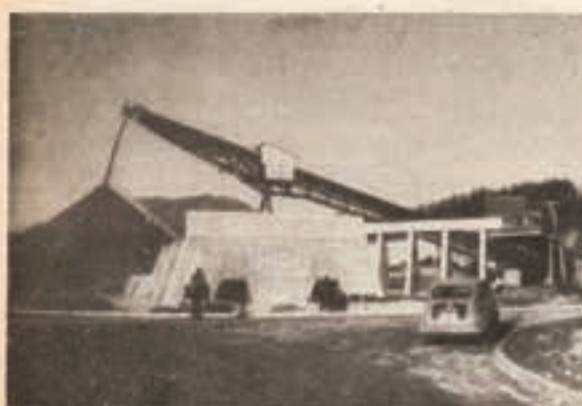
Отворено складиште за издобијену руду има капацитет 60 хиљада тона. То су копаони довољни да флотација нормално ради три дана у случају застоја у експлоатацији руде
