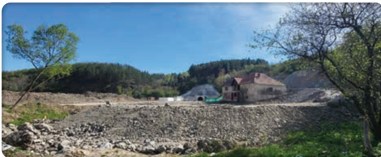
Sl. 4. Tunel kolektora. April 2024.
