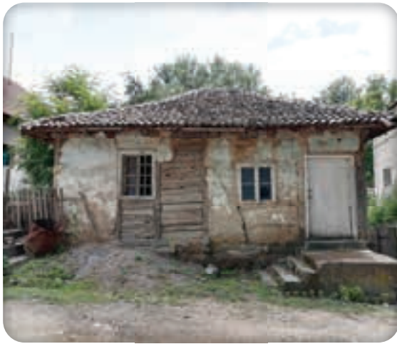
Сл. 11. Северна фасада.
