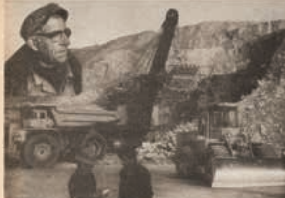
Прве кубике раскривања на привезљском коњу (27. марта 1979.) багерског капацитета издвојено је Јован Мартиновић. До сада је скинуто 30 милиона кубика раскривања и припремљена руда за експлоатацију
