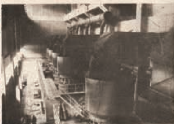
Система „станица“ за припрему руде коју треба да прихвати машини у флотацији је систем секундарног и терцијалног дробљења
